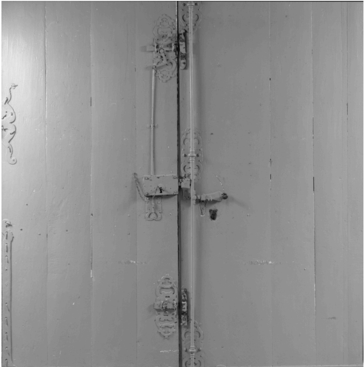
Vue intérieure : détail du système de fermeture de la porte principale.
