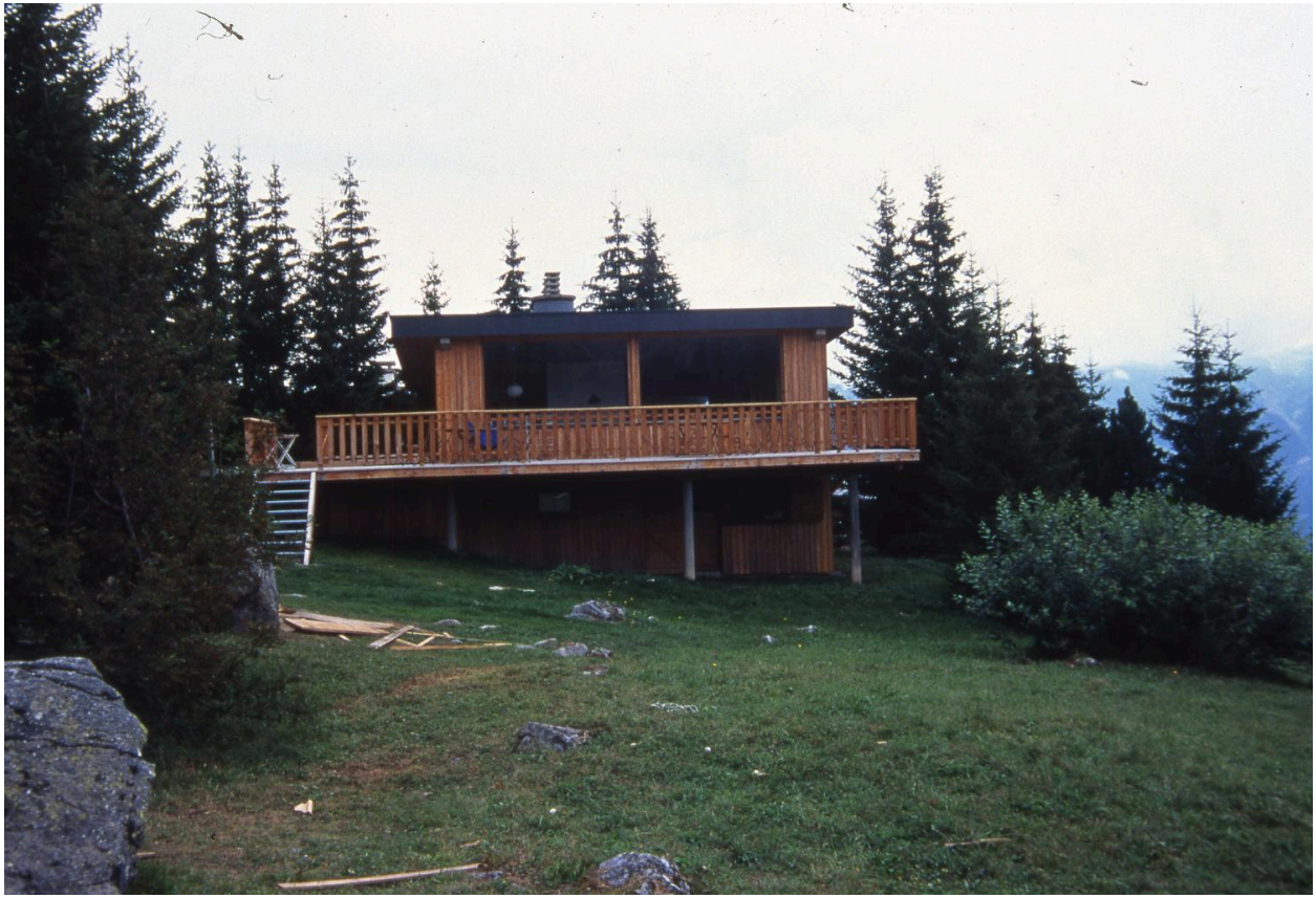
Vue générale depuis le sud
