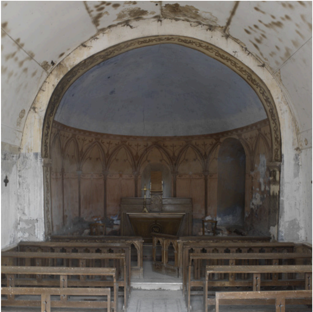
Vue d'ensemble intérieure : bancs de fidèles, clôture de chœur, autel, croix d'autel, peintures.
