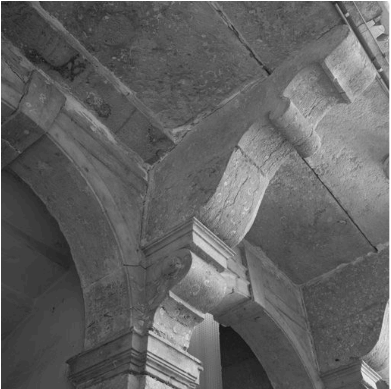
Cour, escalier, détail d'une console soutenant le palier du 4e étage
