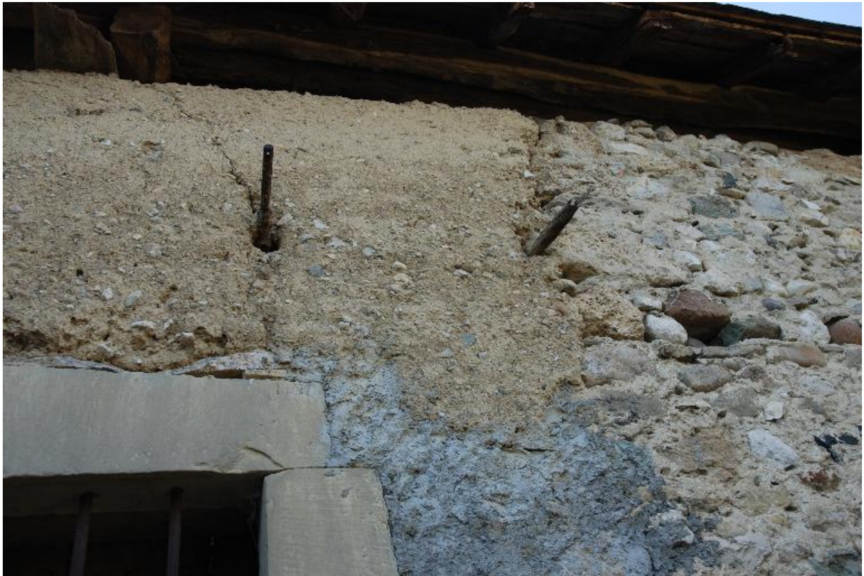
Grange-étable, façade arrière, détail de pisé.
