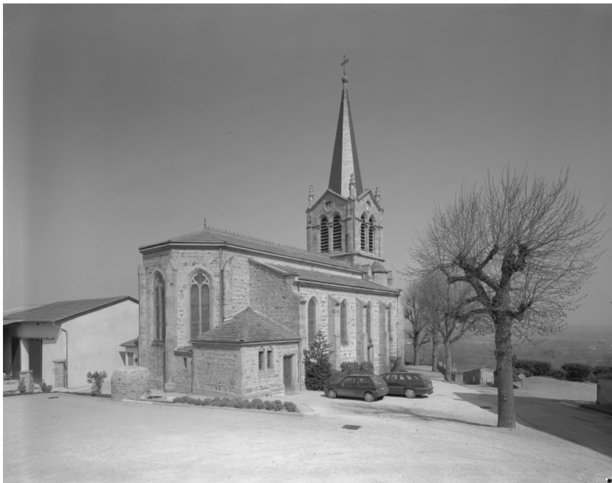
Vue d'ensemble depuis le sud-ouest : trois-quarts du chevet et de la façade latérale gauche (avril 2002).
