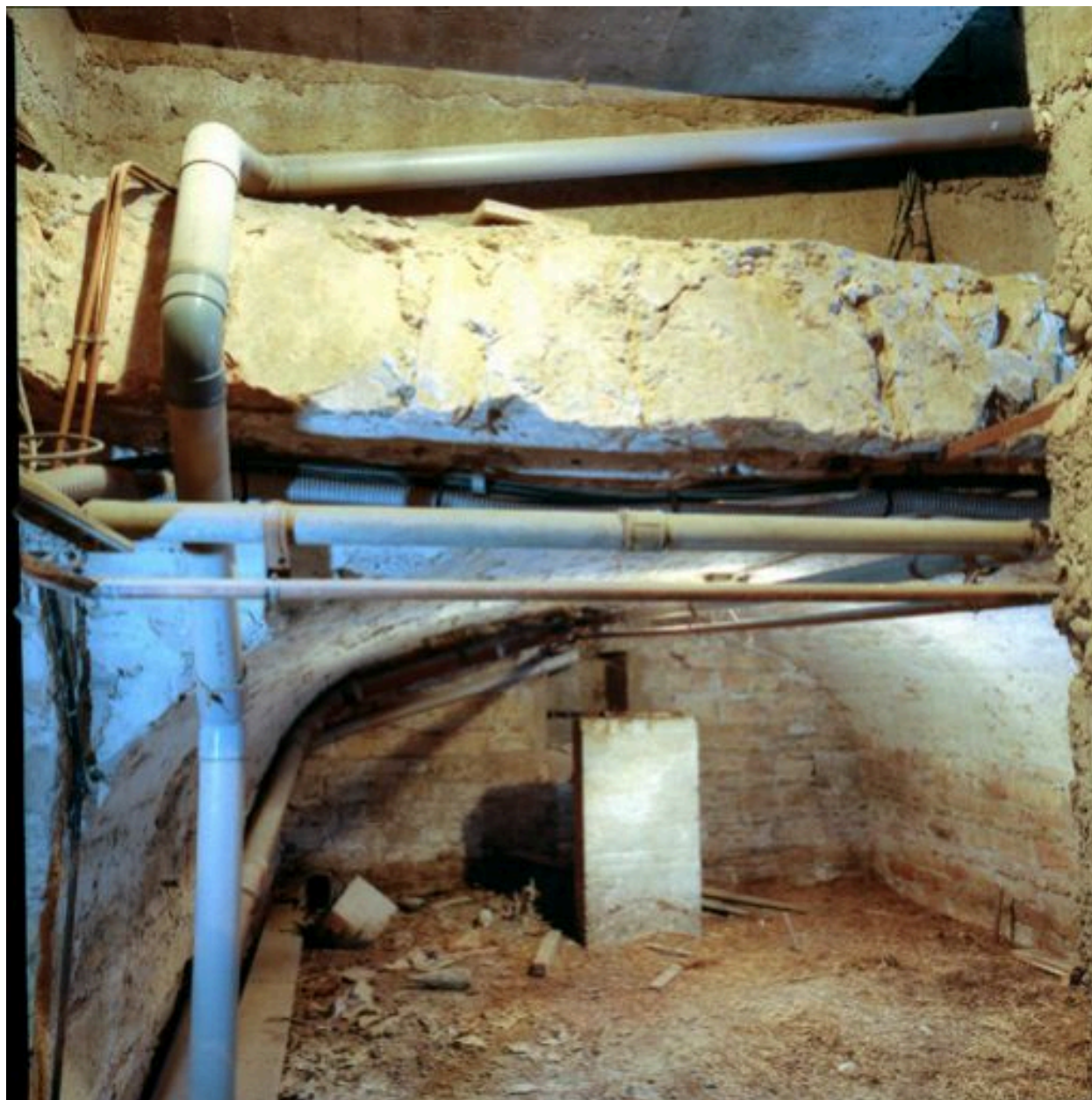
Réutilisation du sous-sol, détail matériaux
