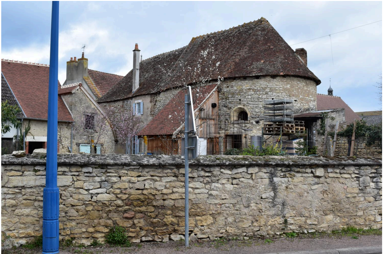
Vue générale du mur gouttereau sud et de l'abside au sud-est
