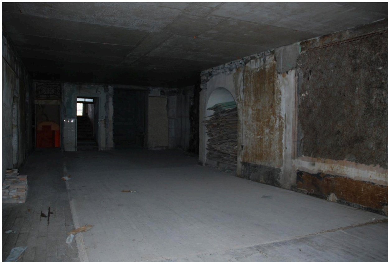
Vue intérieure du 1er étage, depuis le nord.
