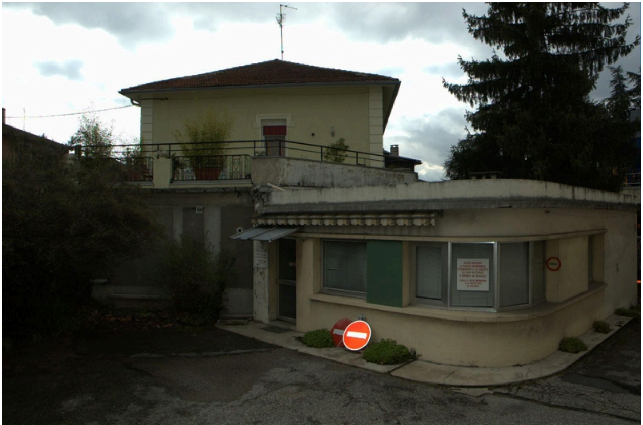
Pavillon d'entrée et maison patronale
