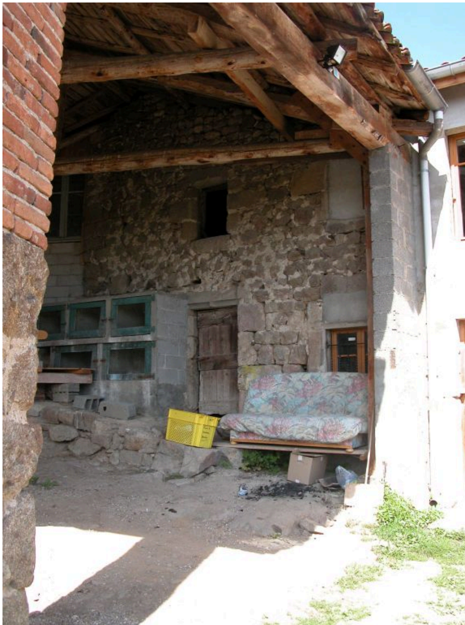
Condamine (1986 AK 261). Ferme, vue d'ensemble de l'ancien logis.
