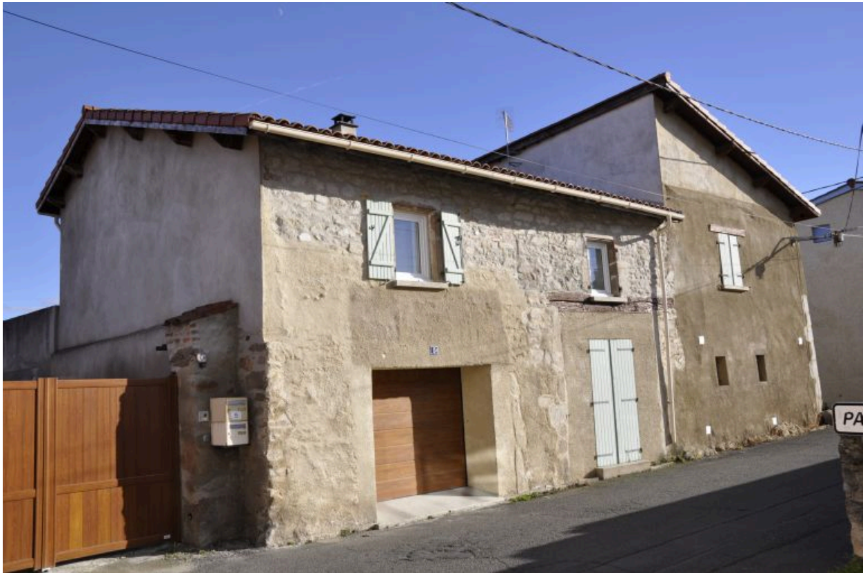
1986 AE 318, 593. 6 rue de la Résistance. Ancienne ferme, vue d'ensemble des élévations sur rue.
