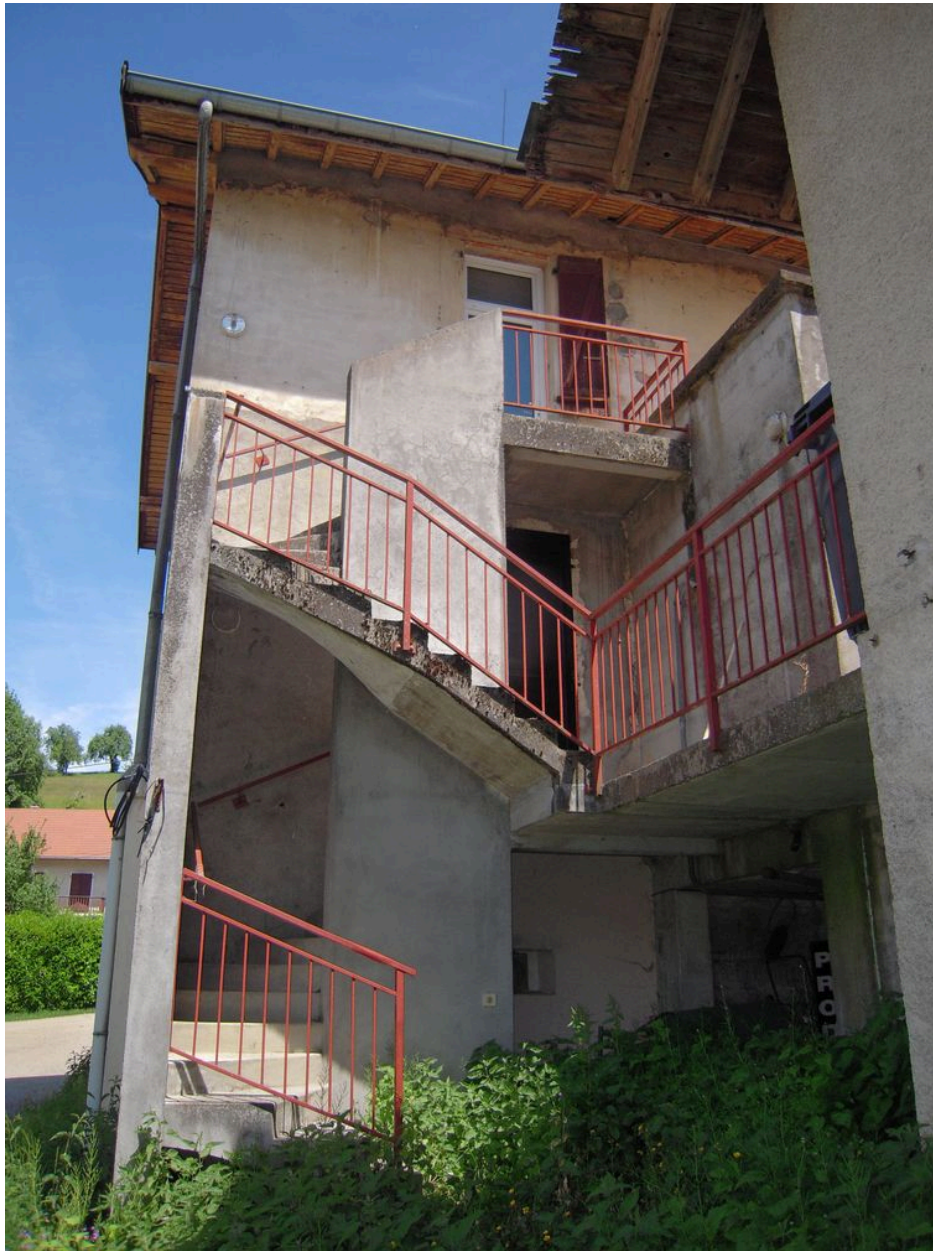
Vue de l'escalier extérieur.
