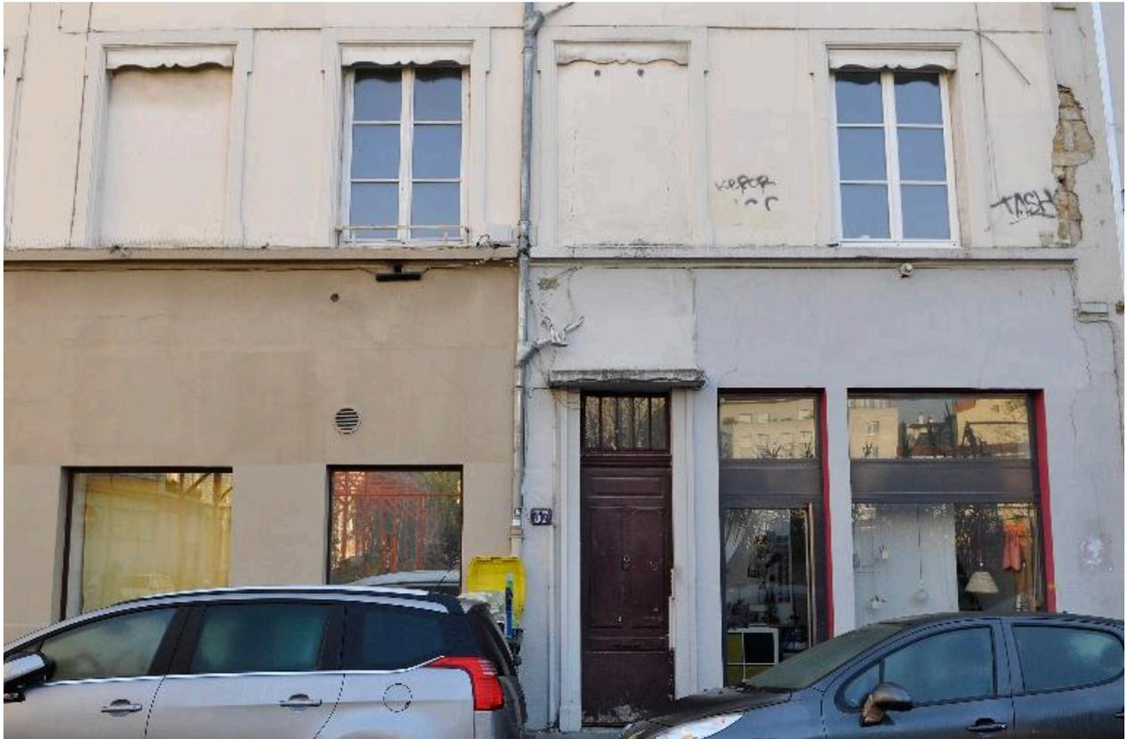
Rez-de-chaussée dénaturé, moellons apparents dans une lacune de l'enduit
