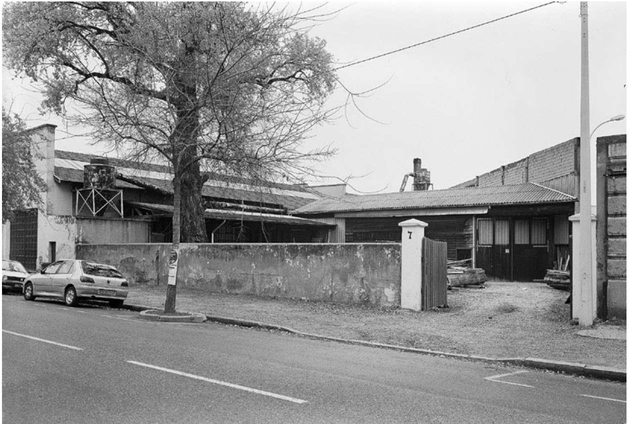
Vue sud-ouest, entrée livraisons
