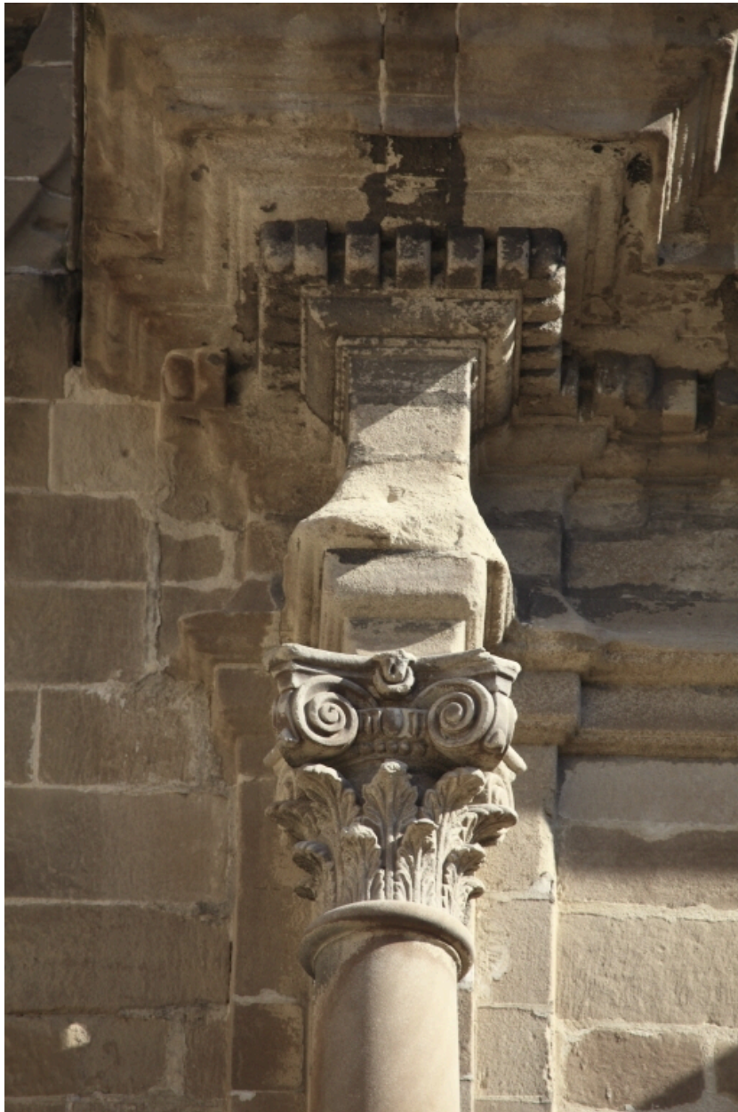
Façade. Détail. Colonne, chapiteau et entablement.
