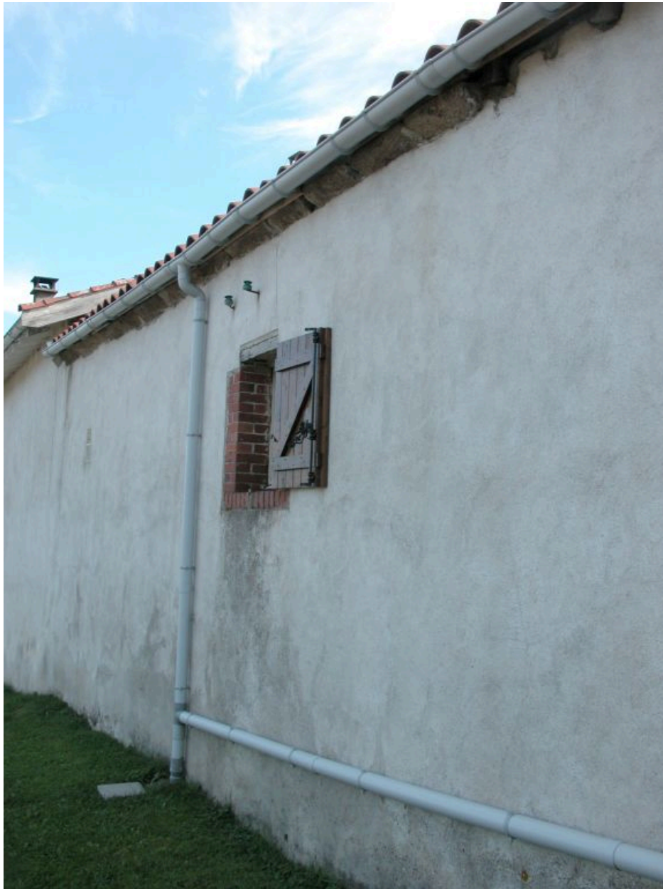
Détail de la partie centrale du mur nord du logis, ferme parcelle 82.
