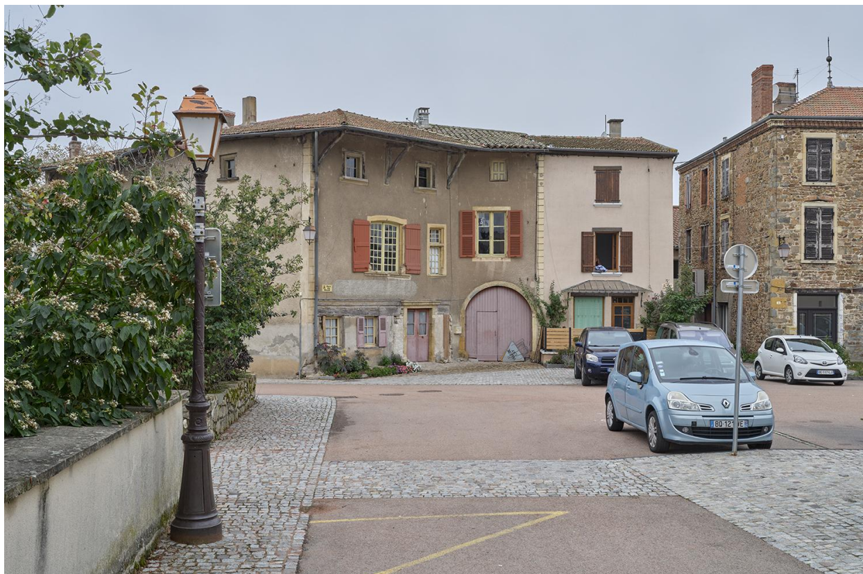
Vue d'ensemble des élévations sud et est de la maison.
