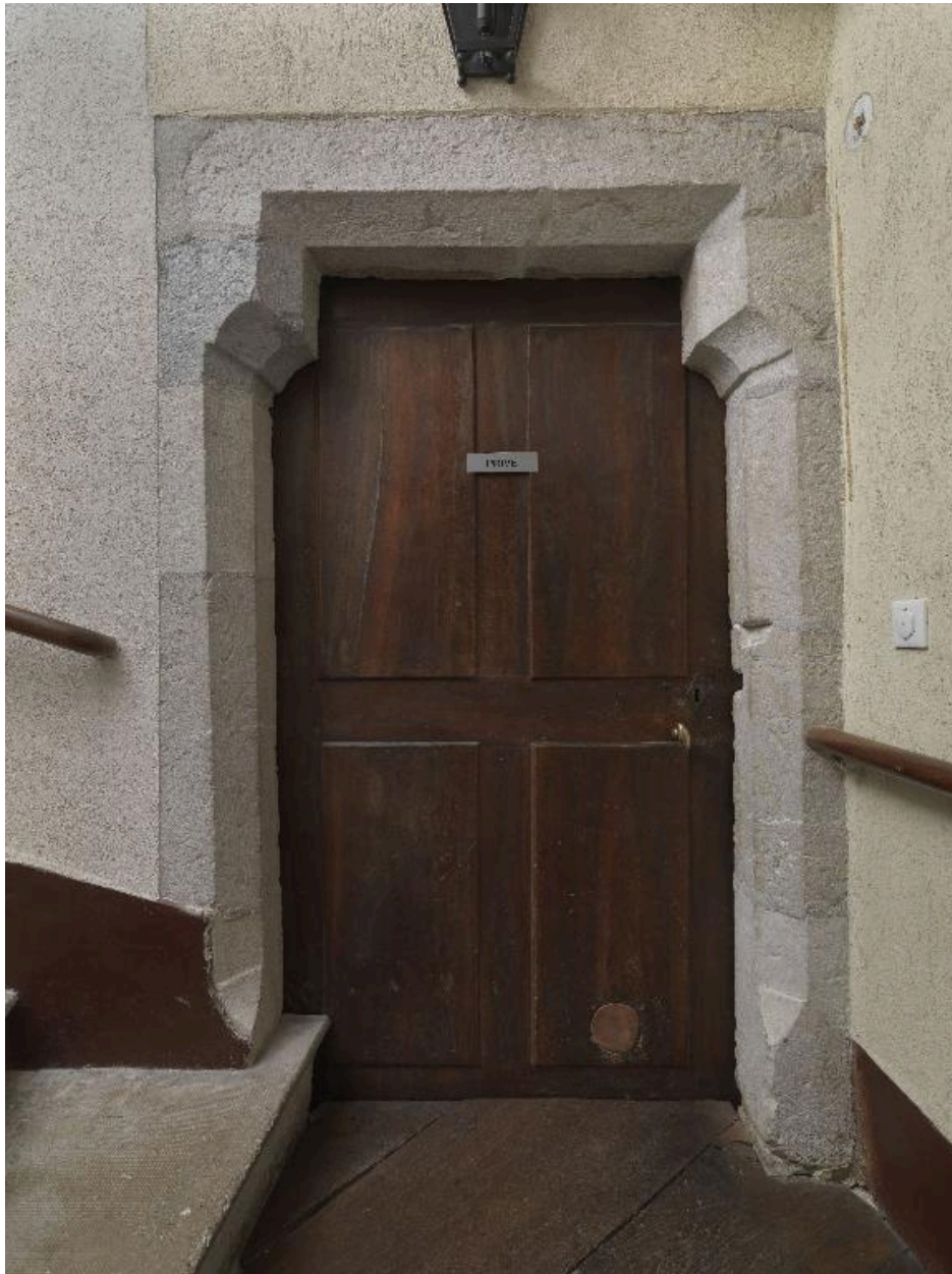
Escalier en vis. Porte du deuxième étage du corps de bâtiments est-ouest (fermée).
