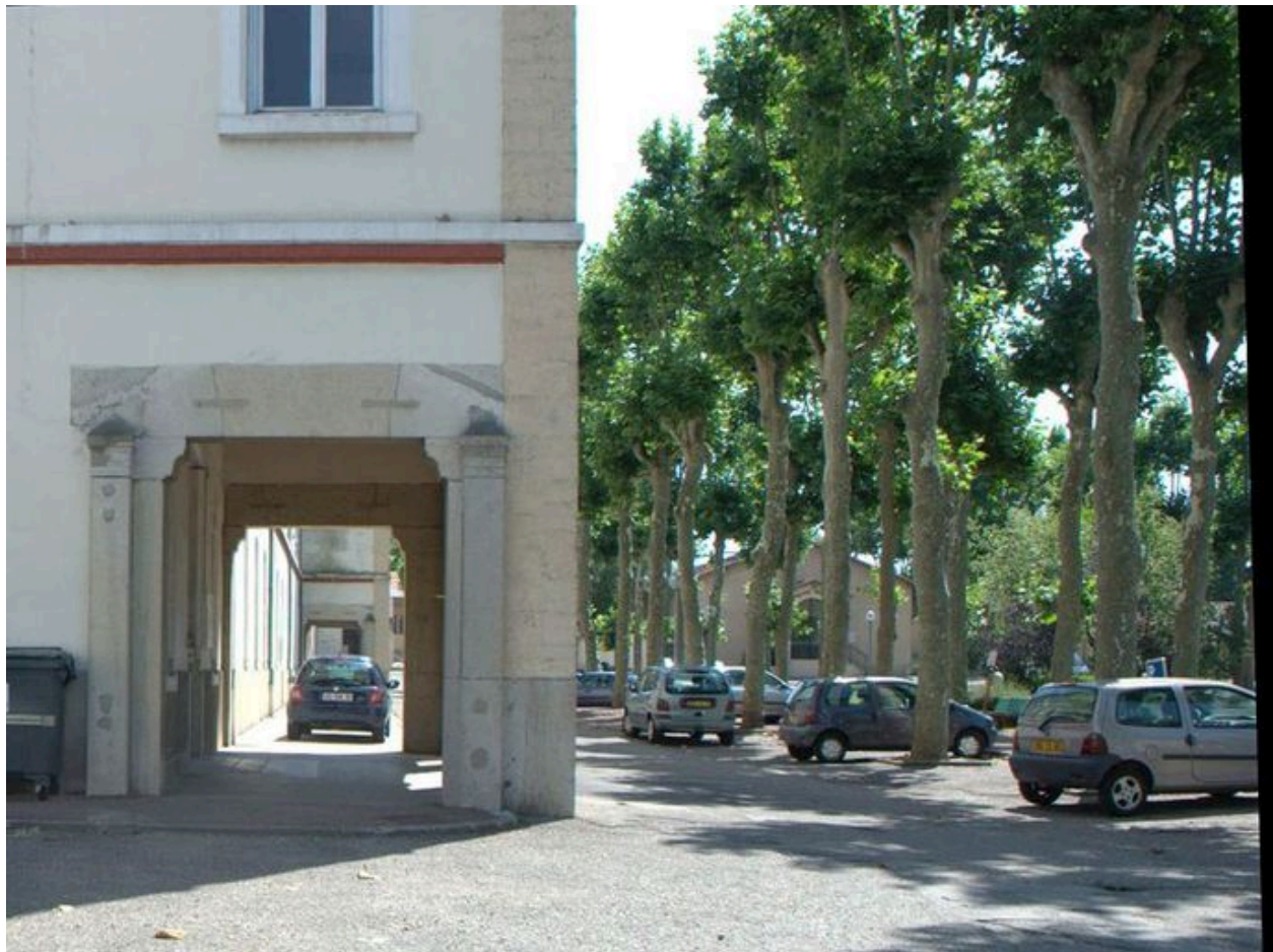
Façade latérale nord, traces du promenoir
