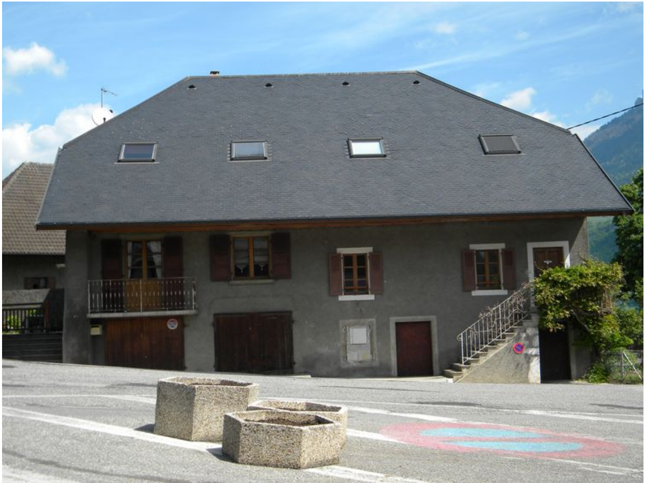
Façade principale d'une ferme à juxtaposition sur la place du village (2008 A3 358).
