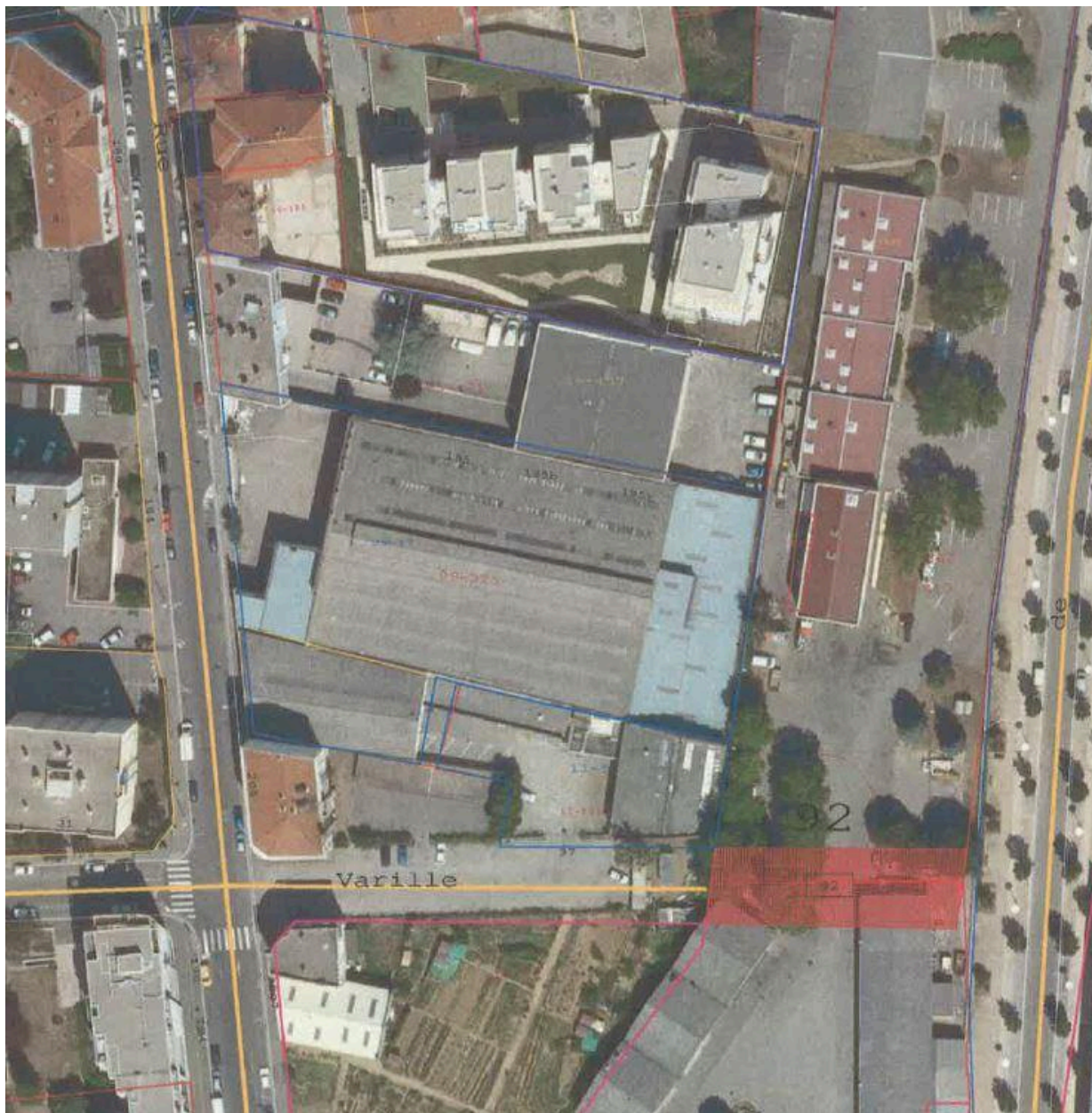
Vue zénithale avant démolition (Google 2009)
