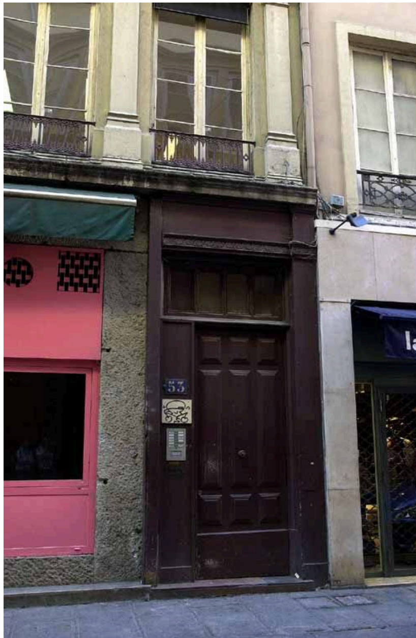
Élévation antérieure : la porte
