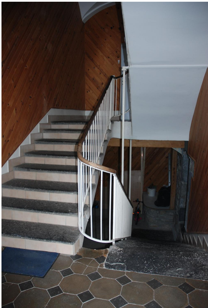
Demeure, vue intérieure : palier du rez-de-chaussée et escalier.
