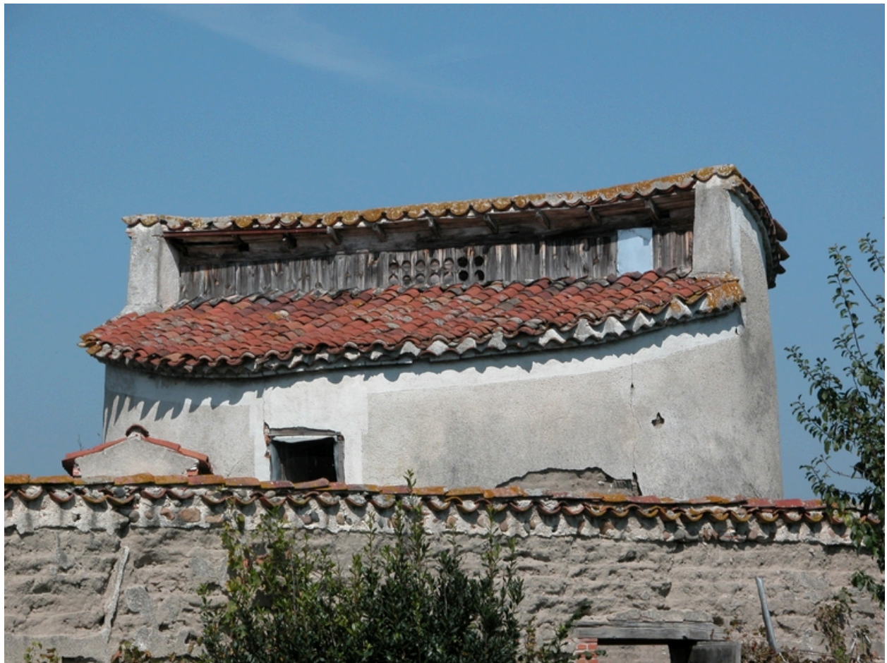
Détail de la partie haute.
