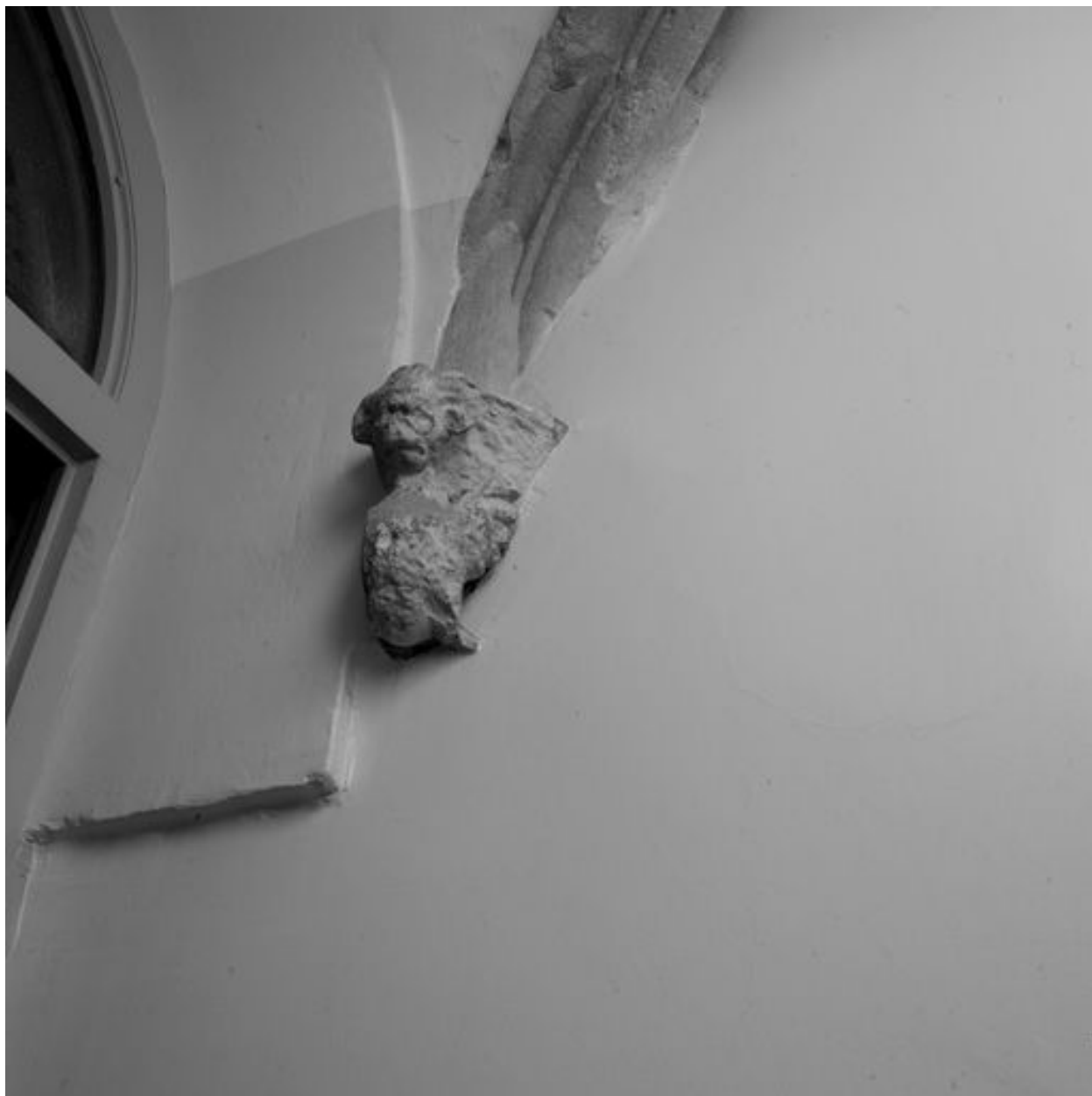
Voûte de l'allée, détail du culot 11
