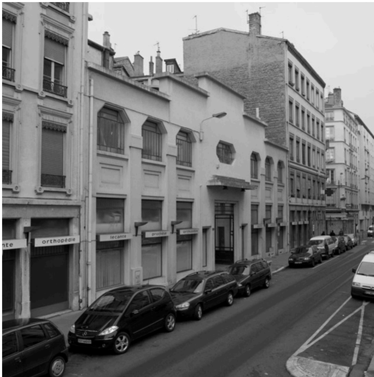
Vue générale sud
