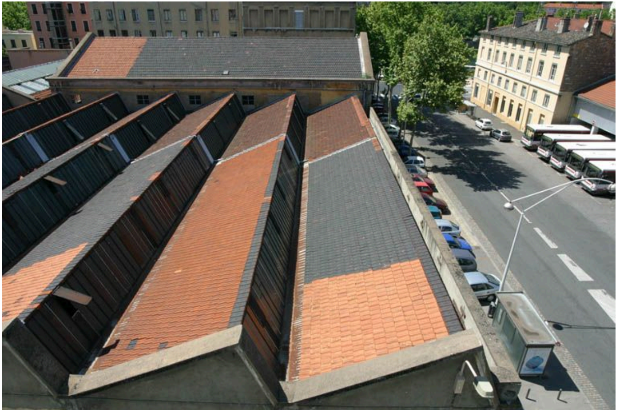
Vue est, toiture
