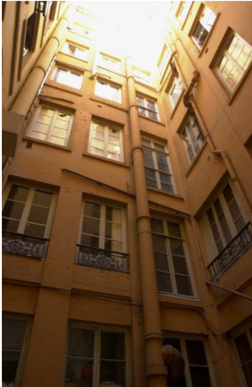
Vue générale des façades sur cour
