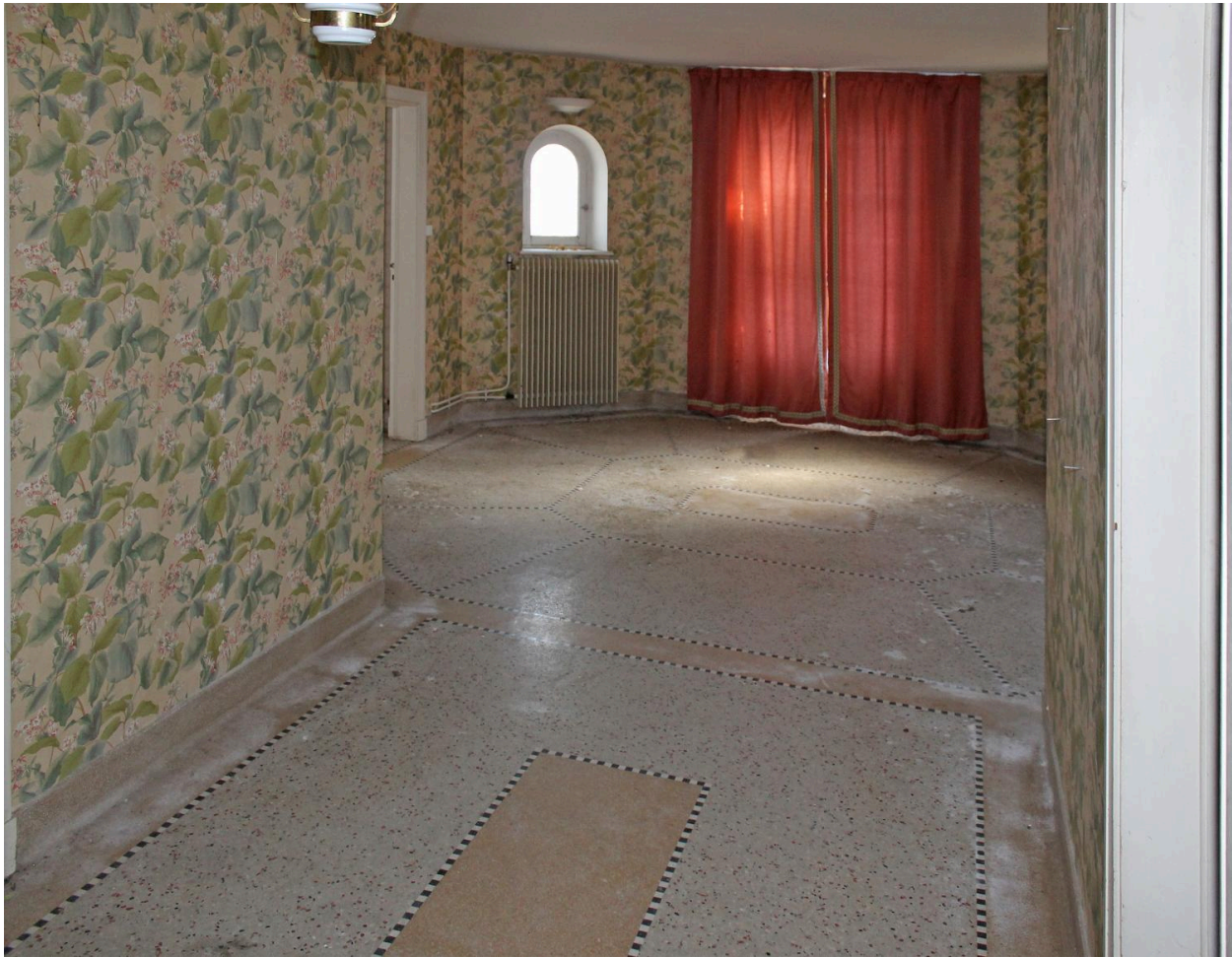
Pérignat-lès-Sarliève, la maison B.* , le vestibule du rez-de-chaussée et son sol en granito et mosaïque.
