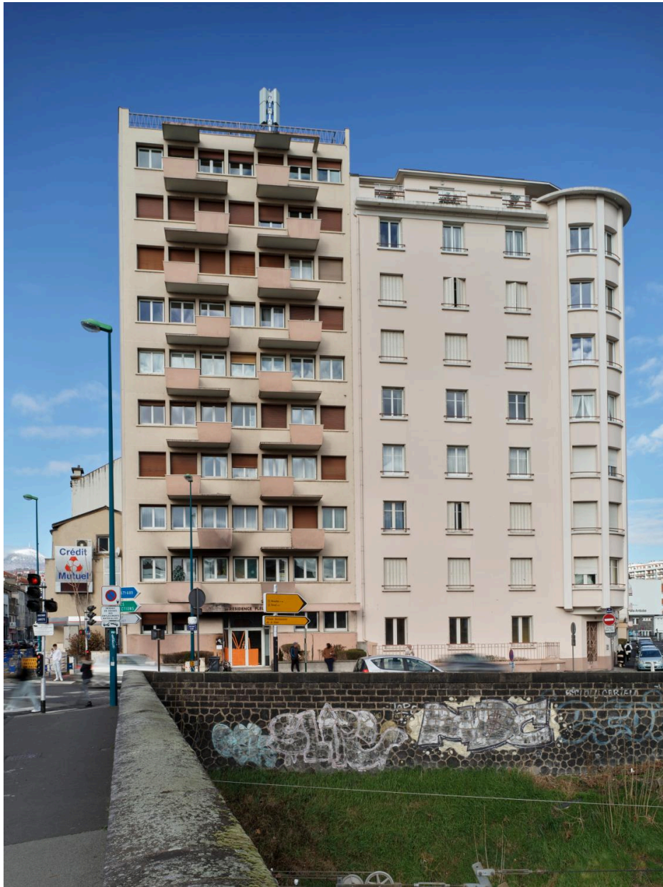
Façade sur le boulevard Fleury
