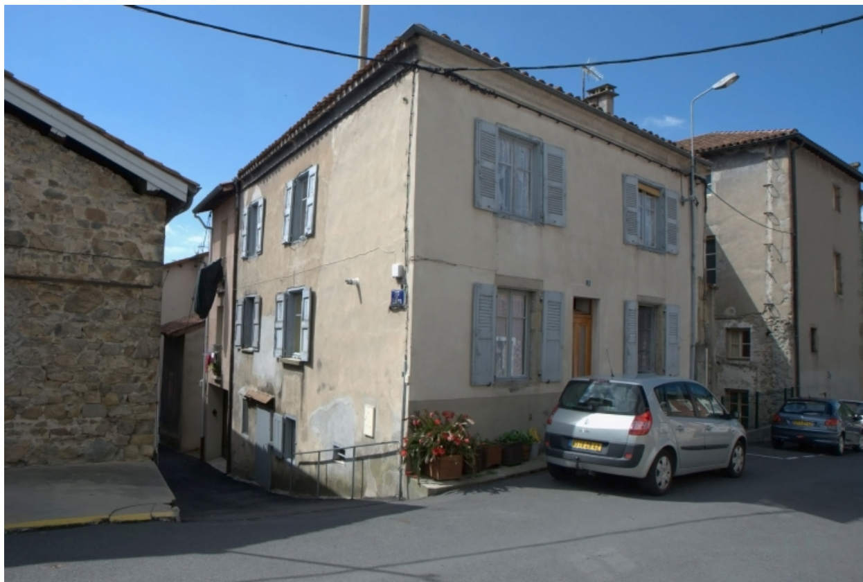
Îlot 3.Ecoles (rue des) 05 / Sordet (rue du) 01. Vue générale des façades sur rue.
