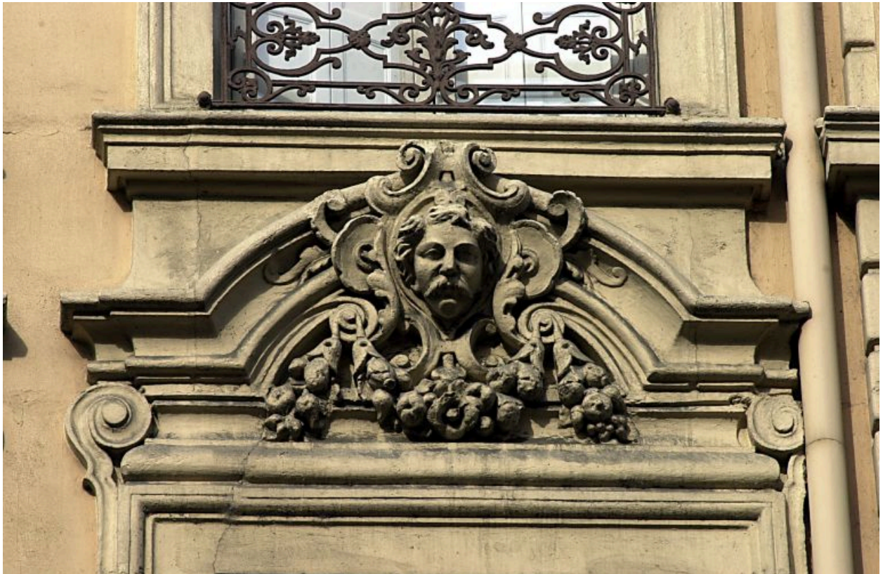
Façade principale, 2e étage, détail de la 3e fenêtre à gauche
