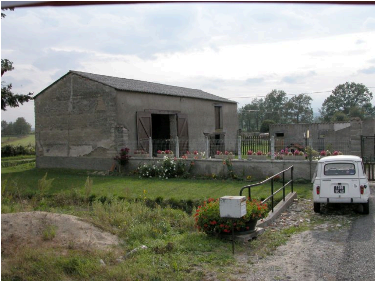
Vue d'ensemble de la grange-étable
