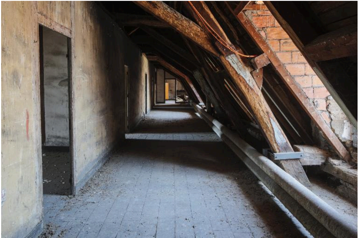
Bâtiment G. Combles
