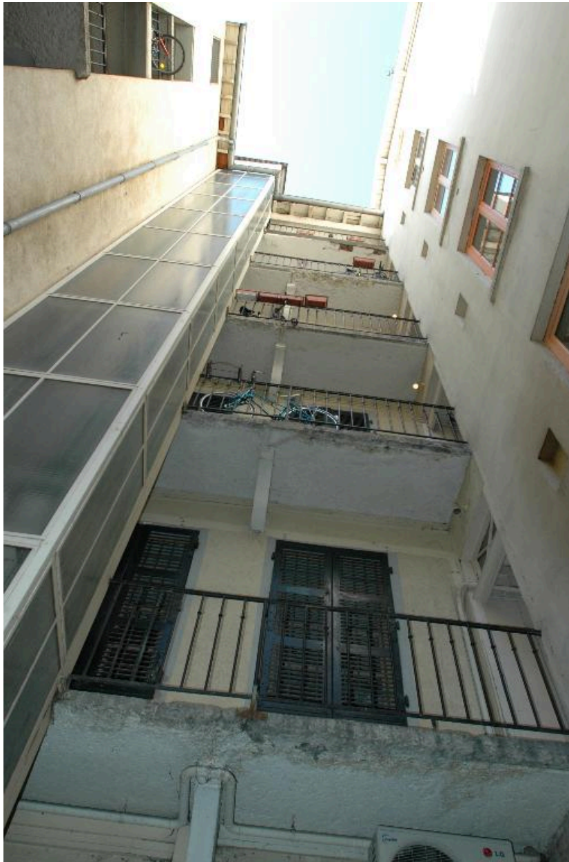
Bâtiment sur rue Passet : vue des coursières longeant la façade sur cour
