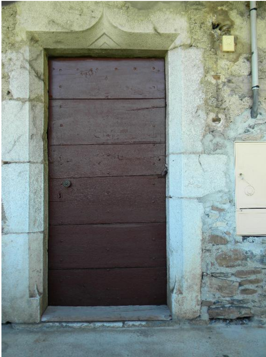
Détail de l'encadrement de la porte du logis avec son accolade.
