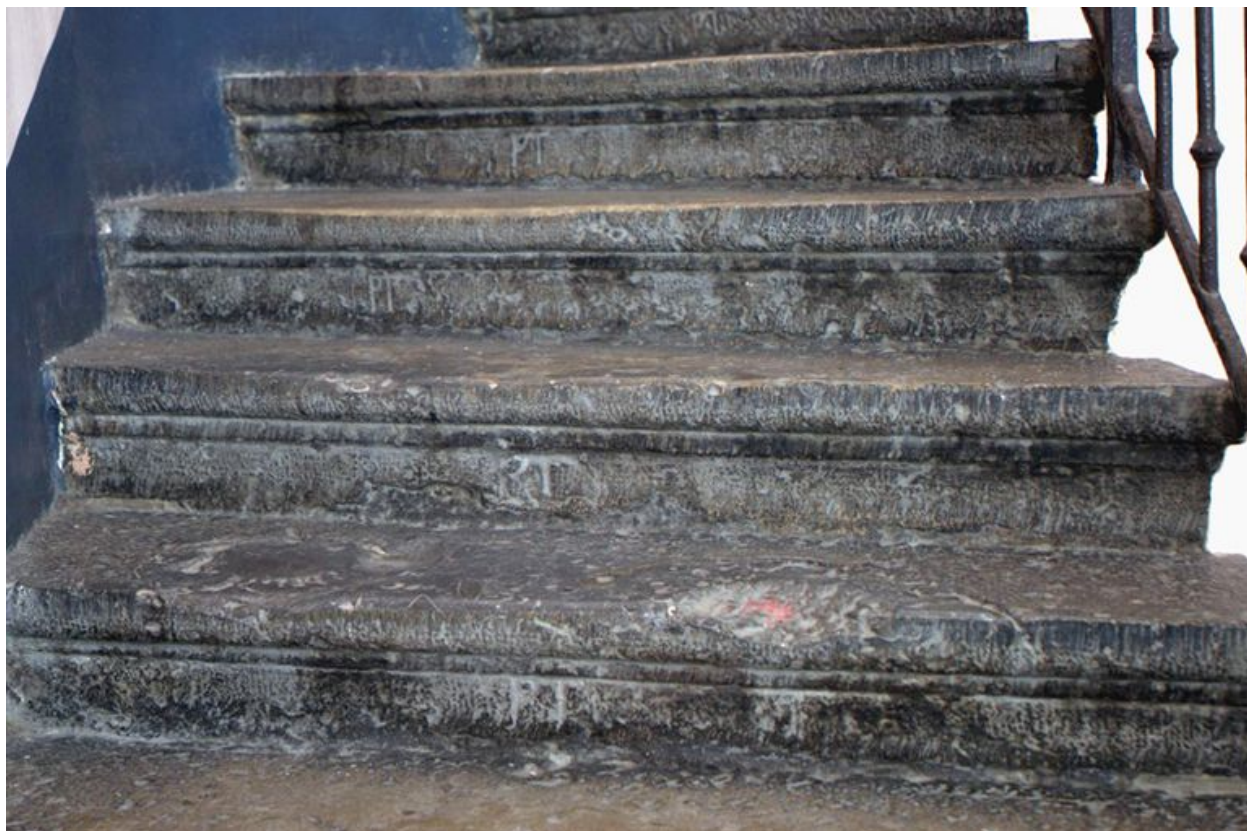
Marques de tâcheron, troisième volée de l'escalier
