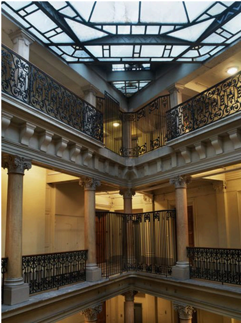
Vue de la colonnade du grand hall (4e étage et étage de combles).
