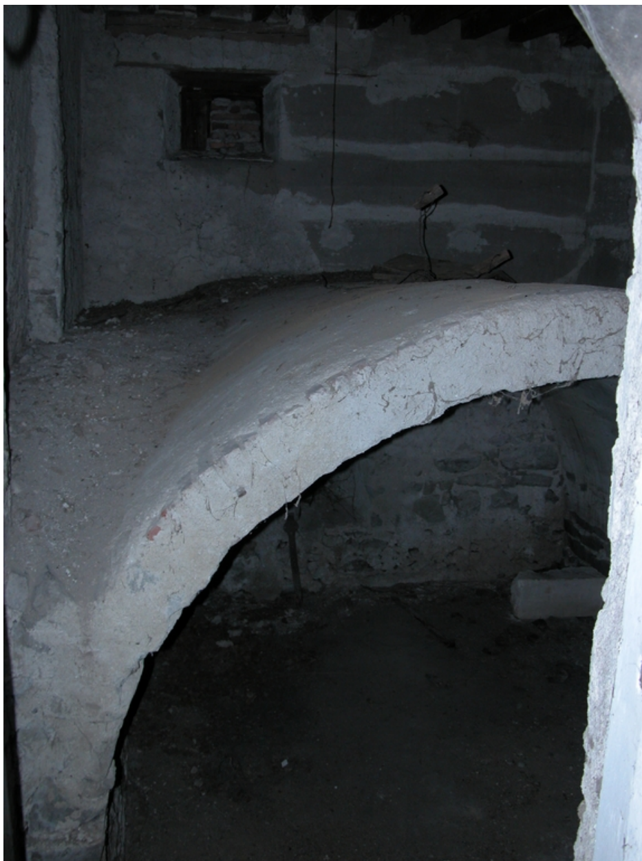
Vue intérieure du rez-de-chaussée : cellier voûté.
