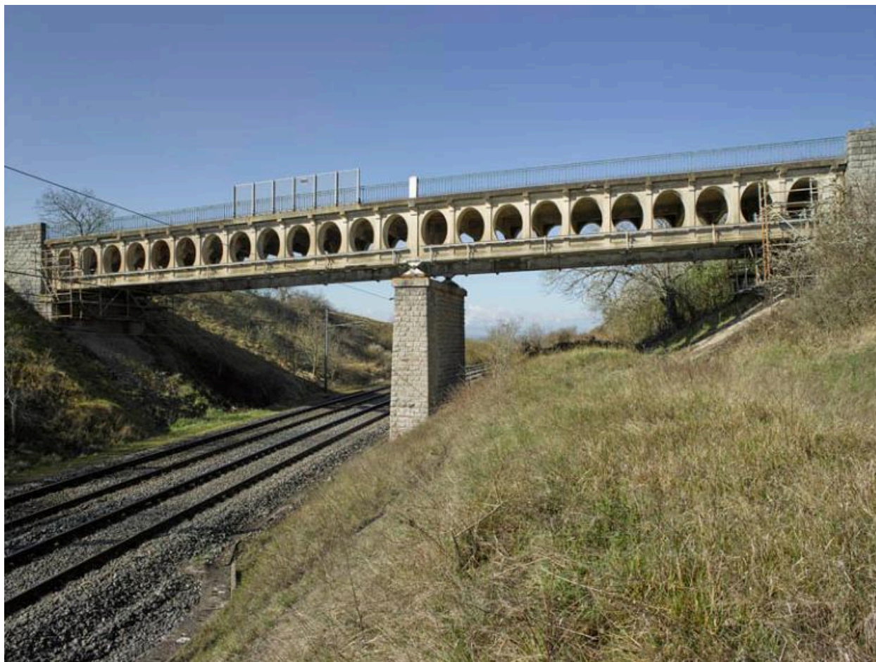
Le pont de Randan depuis les abords de la voie ferrée.
