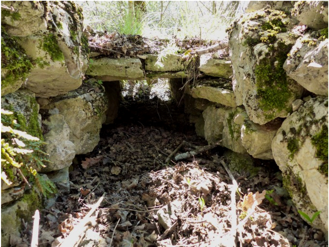
Canal de pente, au quartier de Font Nouvelle. Ponceau en lauze.
