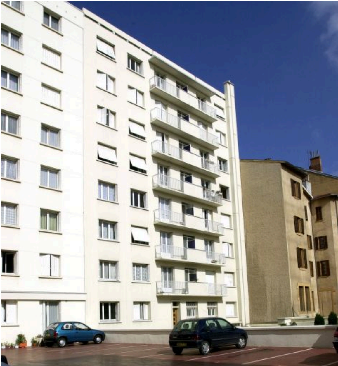
Élévation postérieure rue Quivogne depuis le sud
