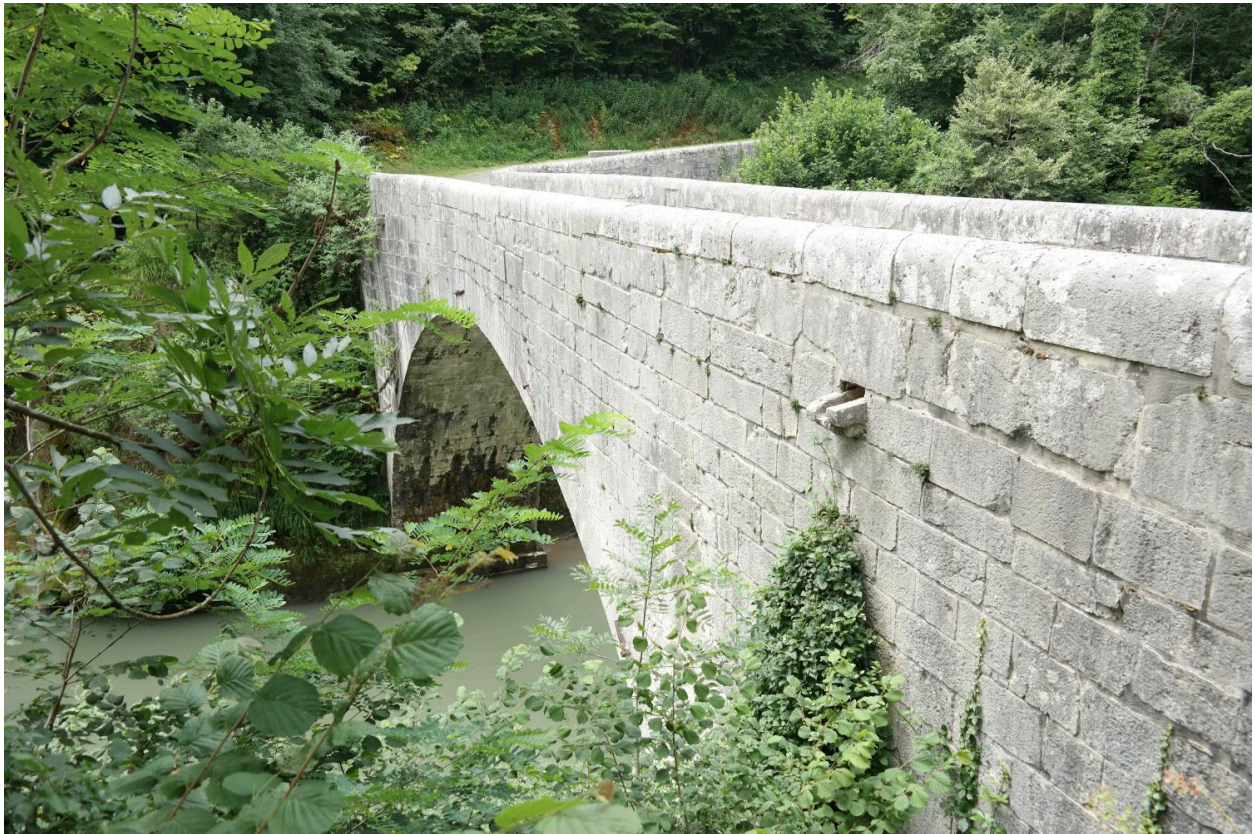
Pont Coppet, vue de la face aval
