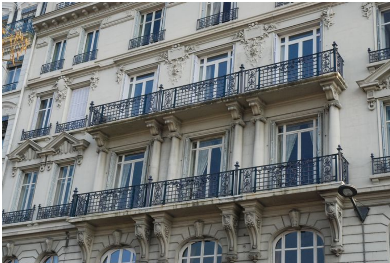
Détail de l'élévation sur quai : balcons filants du 2e et 3e étages
