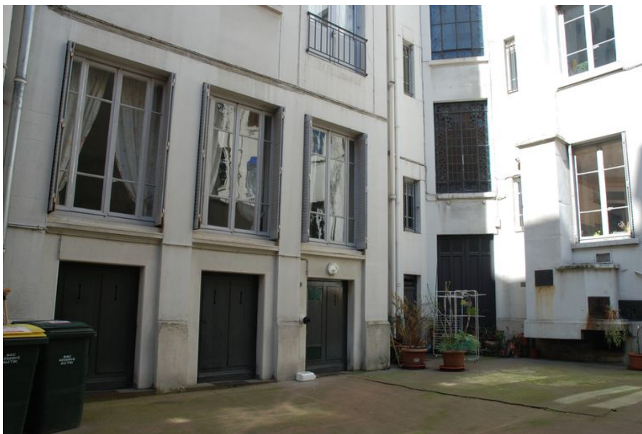
Elévation sur cour, remises en soubassement
