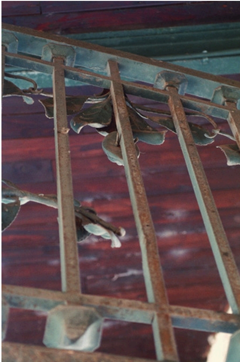
Détail attache et soudure
