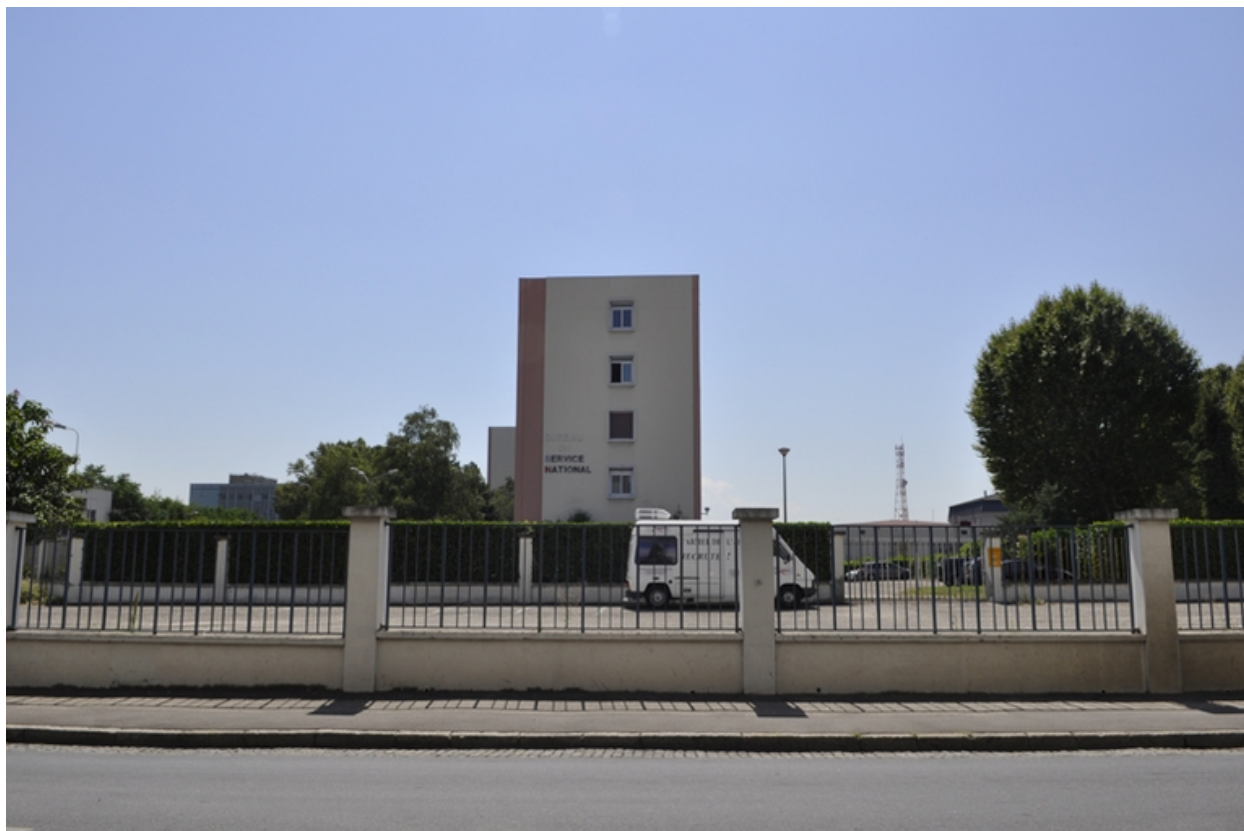
QGF. Bâtiment des années 70, vue prise depuis la rue Nadaud.
