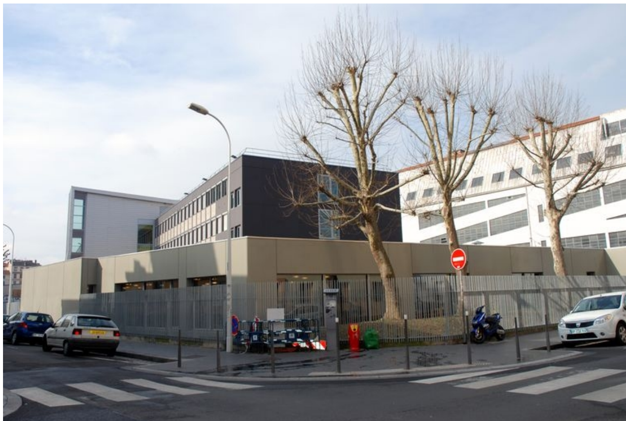
Vue de l'élévation nord, avec la cafétéria au rez-de-chaussée, depuis l'angle des rues Salomon-Reinach et Capitaine-Robert-Cluzan.
