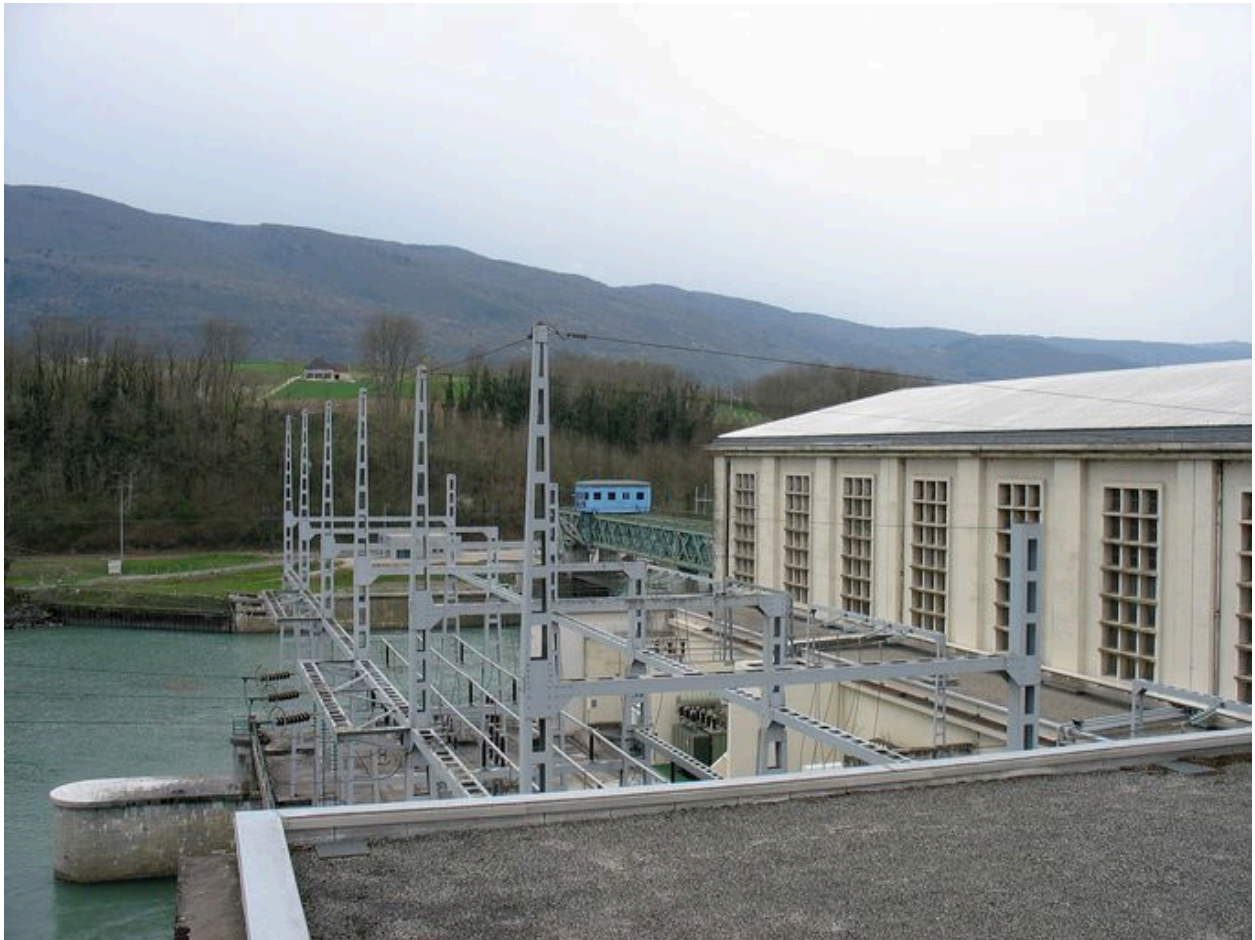
Vue de l'usine-barrage, depuis la rive gauche (est)
